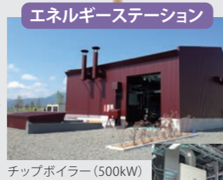
チップボイラー(500kW)を主熱源とするエネルギーステーション。運営は紫波グリーンエネルギー株式会社
