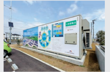
大型蓄電池(480kWh) (画像:HOPEウェブサイトより)
