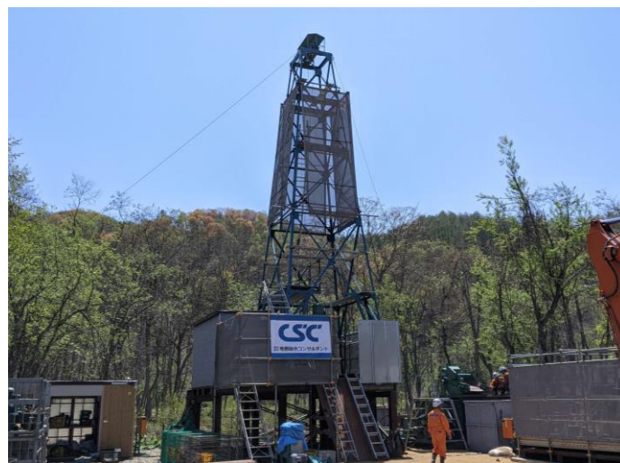
(写真：地下約 400m の採掘跡に向けて掘削)
